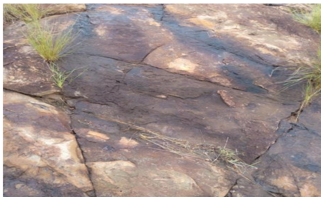
. Fig.2 Rochas homogéneas com falhas, fissuras e fraturas
